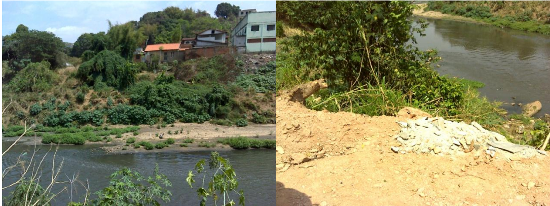
Figura 07: fundo da casa do morador, construção de terraço na tentativa de conter a enchente.
